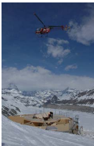
Die Holzbau-Arbeiten: Ein anspruchsvolles Puzzle aus 420 Einzelteilen. (Fotos: Hans Zurniwen)
